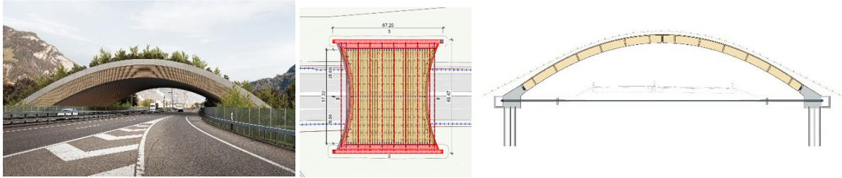
Figure 9. Wild life overpass «Biberlikopf», visualization and timber arch planned, source: Nightnurse Images, Zürich, dsp Ingenieure + Planer AG, Timbatec Holzbauingenieure Schweiz AG
