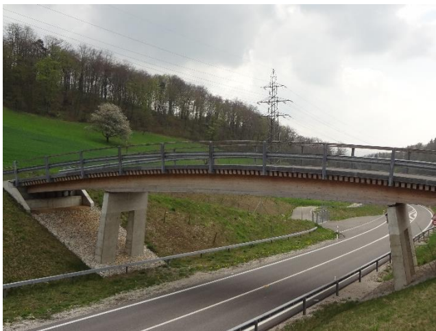
Figure 25: Horenbrücke, Canton Aargau, built 2008, length: 30.87 m, span: 6,25 – 17,32 – 7,30 m, 40 tons, block glued girder bridge, Design: Makiol + Wiederkehr, Beinwil, Wilhelm+Wahlen, Aarau, Zimmermann Architekten, Aarau, Pictures: A. Müller BFH
