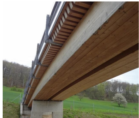
Figure 25: Horenbrücke, Canton Aargau, built 2008, length: 30.87 m, span: 6,25 – 17,32 – 7,30 m, 40 tons, block glued girder bridge, Design: Makiol + Wiederkehr, Beinwil, Wilhelm+Wahlen, Aarau, Zimmermann Architekten, Aarau, Pictures: A. Müller BFH
