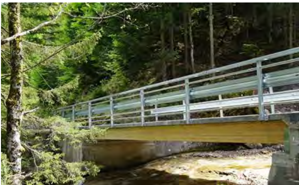
Figure 29: Fruttlibrücke in Arth, Canton Schwyz built 2020, Span: 10,45 m, 40 Tons, Timber- UHPC composite structure, Design: Edgar Kälin, Einsiedeln, Neue Holzbau AG, Lungern, Prof. E. Brühwiler EPFL Lausanne [15], Pictures: E. Kälin
